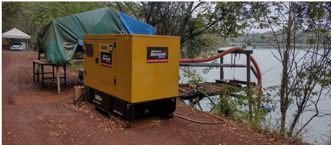
Figura 2 – Gerador utilizado para alimentação do conjunto motobomba para captação forçada da Represa Municipal
